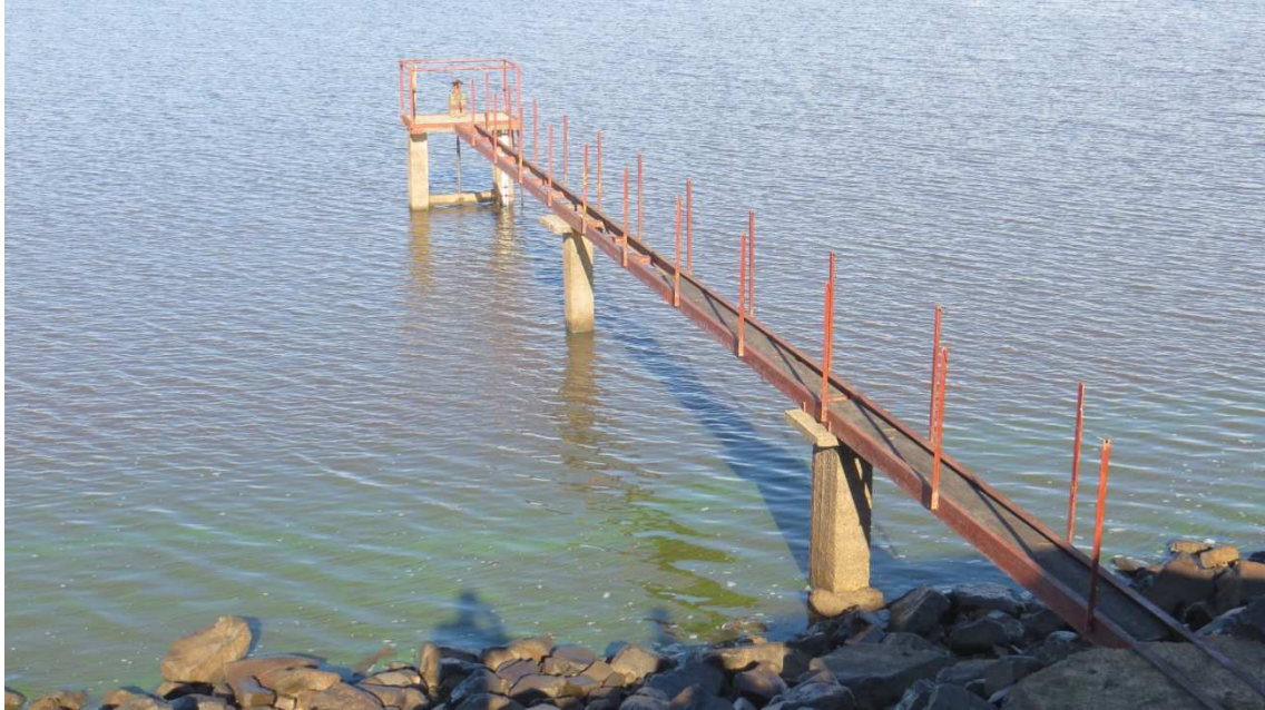
Figura 3-2: Torre de operación de la compuerta de fondo.
