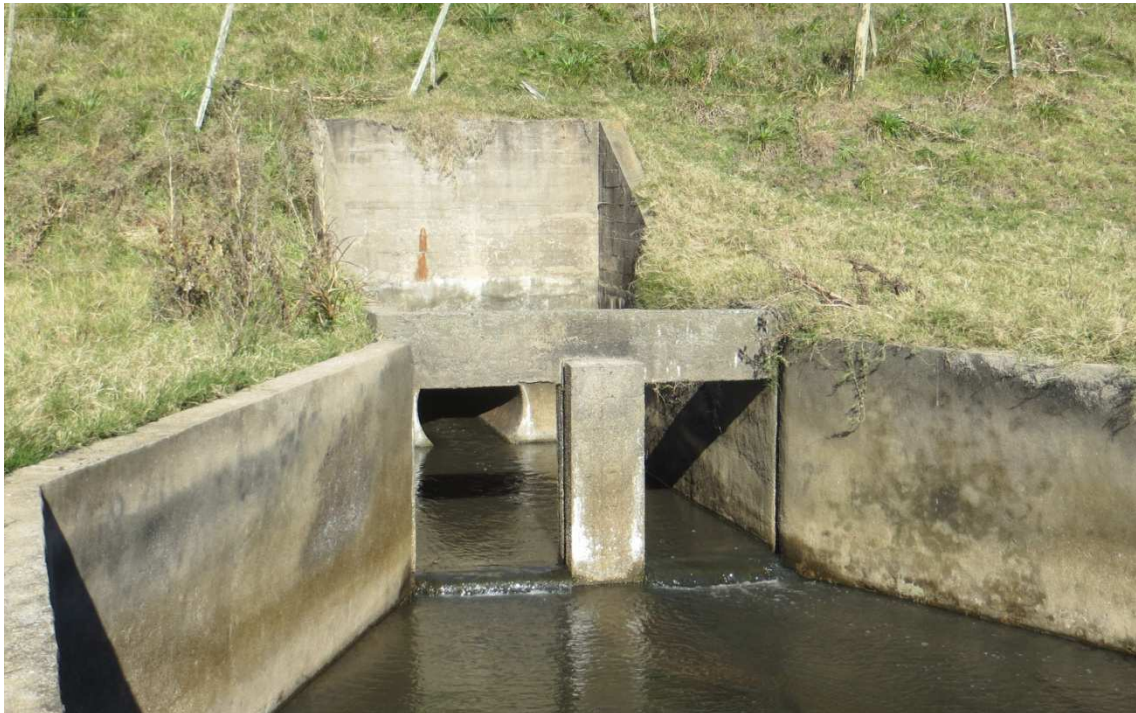
Figura 3-3: Descarga de la obra de toma.
